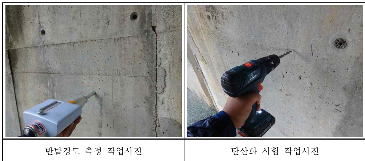
[그림 3.1] 내구성조사 사진
